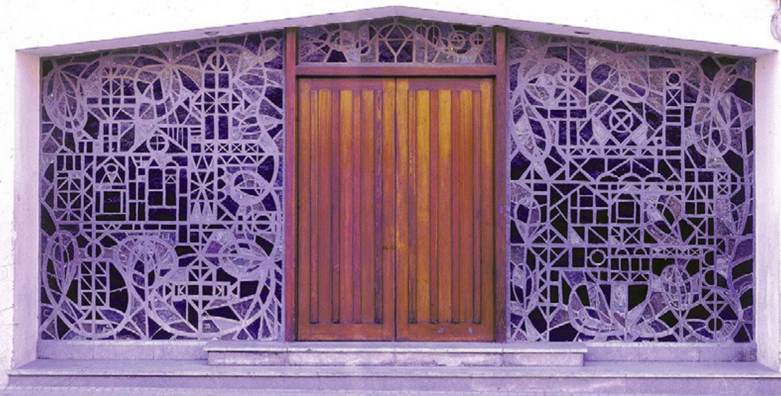
1969 Dominiques. Pont Major. 2,60 x 4,00 m. Ciment armat.
