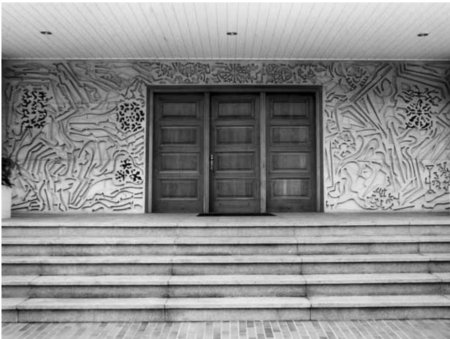
1978 Casa Rigat. Olot. Girona. 260 x 700 cm Ciment encofrat.
