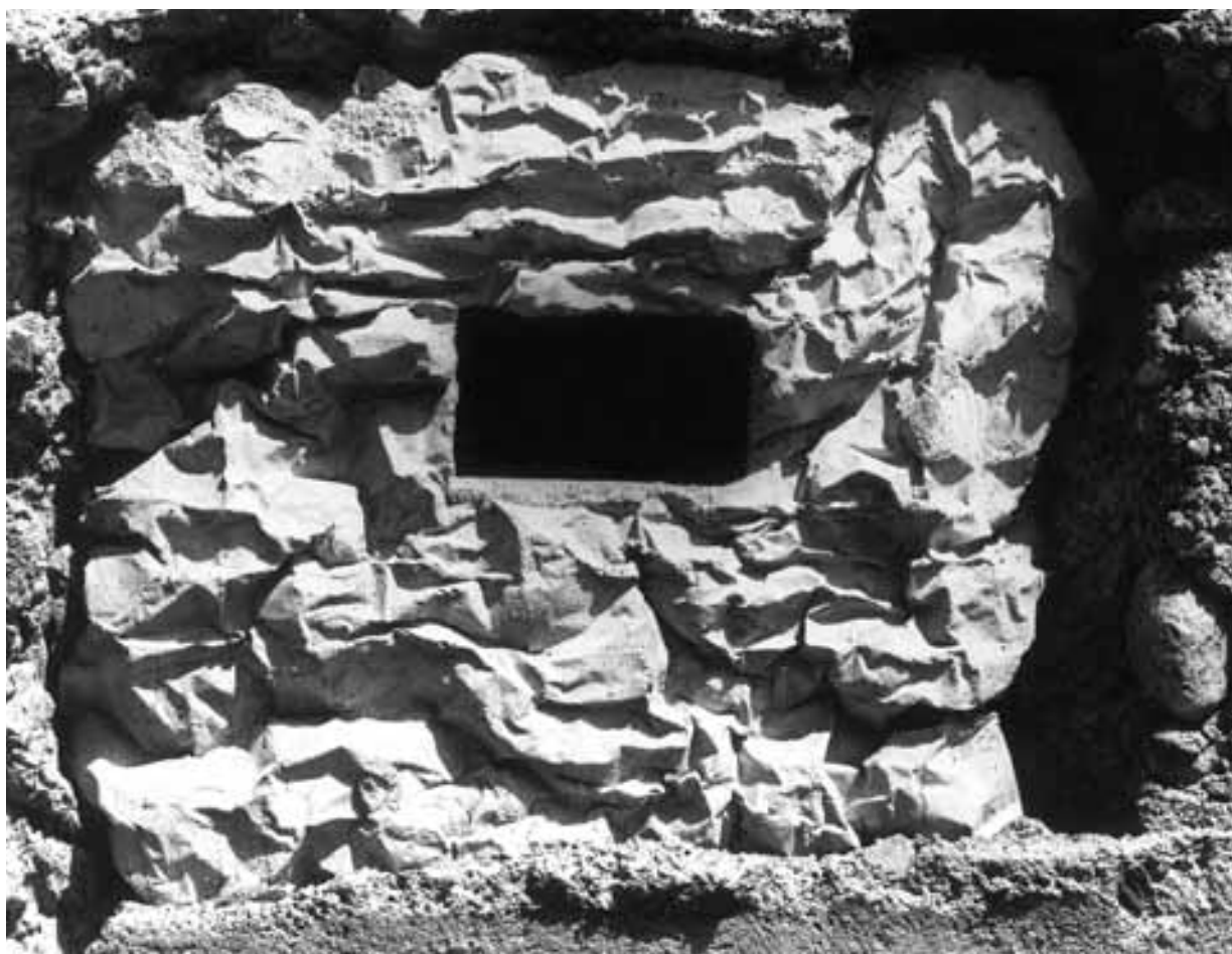
1969 Casa Fita-Rodeja. Bloc de ciment.
