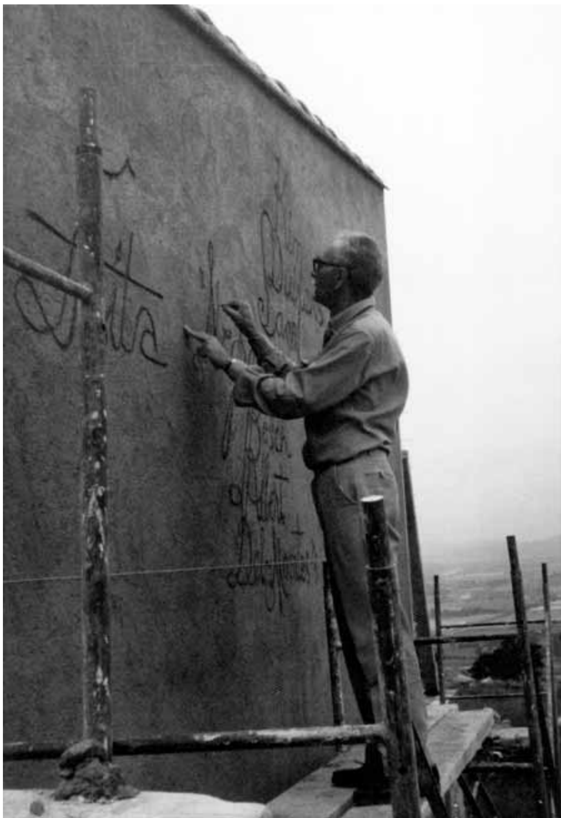
1969 L'arquitecte Masramon, autor del projecte de la casa, gravant a la paret amb els noms dels qui han intervingut en la construcció.
